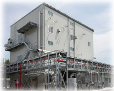
新工場の建設
