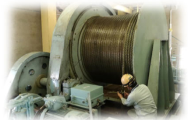
ダム水門設備の点検
