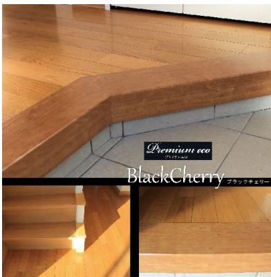
フローリング・玄関框
